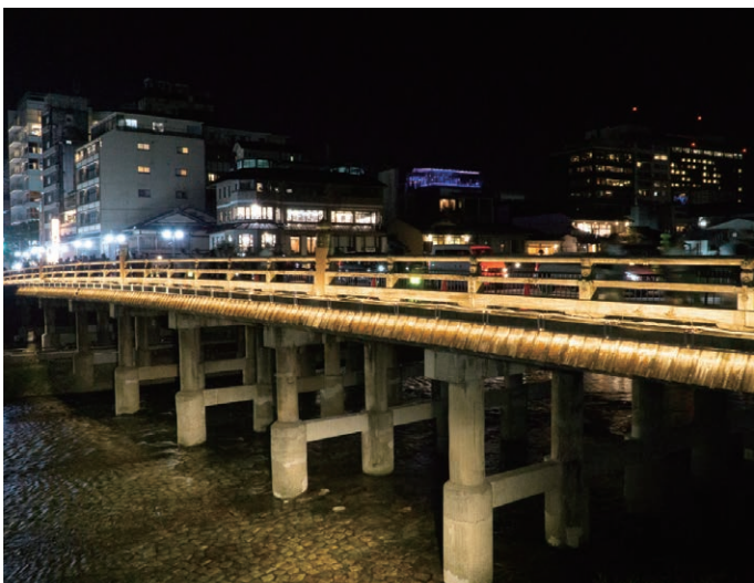
高欄と桁隠しを照らすライン照明は、歩行者から直接光源が見えないように設置されている。さらに離れた位置から橋脚に対して投光照明を行い、橋の輪郭を浮かび上がらせている。
