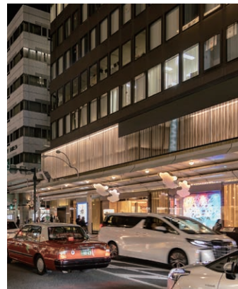
鉛直面の明るさが賑わいをつくっているエントランスの事例
