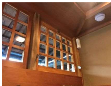
排煙窓の設置、自動火災報知設備（熱感知器）
