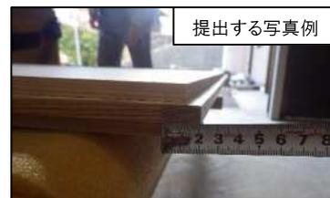
写真2-1 雇い実の断面寸法が確認できる写真
