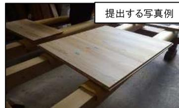
写真2-2 雇い実の施工が確認できる写真
