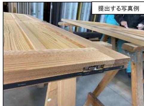
写真3-1 戸下部に取りつけた加熱発泡材が確認できる写真
