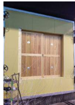
実大実験（掃き出し窓雨戸の性能を検証）
