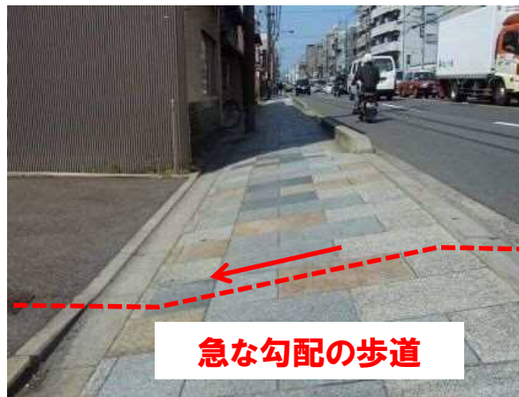
歩道が狭く、勾配の急な箇所が存在
