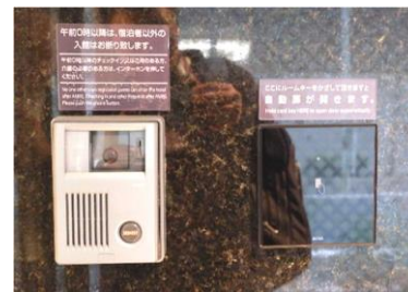
出入口に設けられたカメラ付き インターホン
