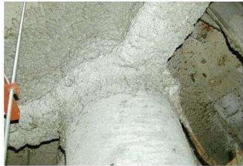
吹付アスベスト (鉄骨耐火被覆材)
