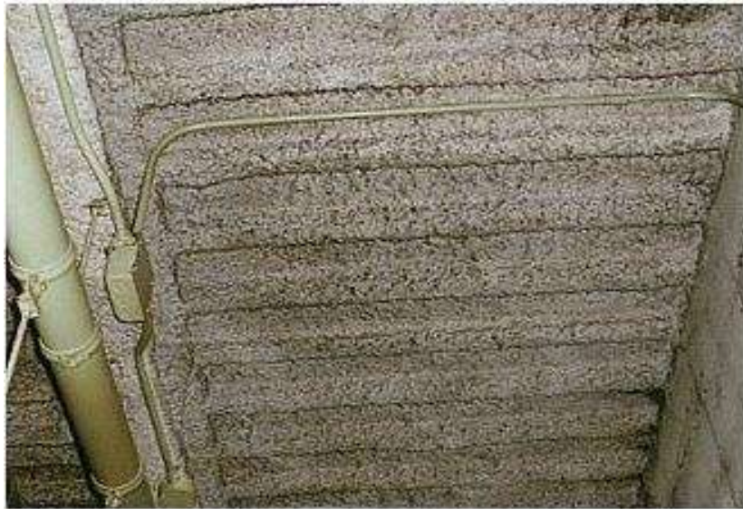
アスベスト含有吹付ロックウール (天井断熱材)
