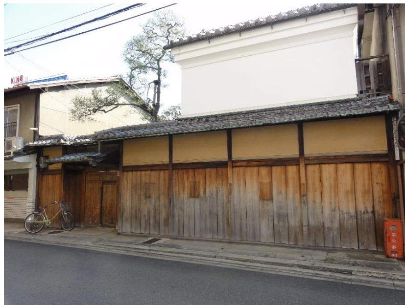
② 建物外観
