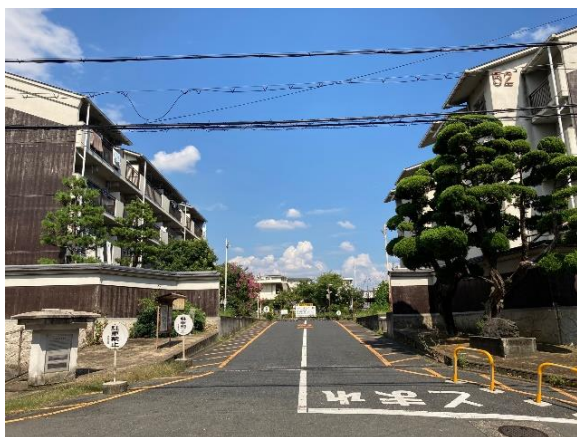
団地西側の正面入口部
