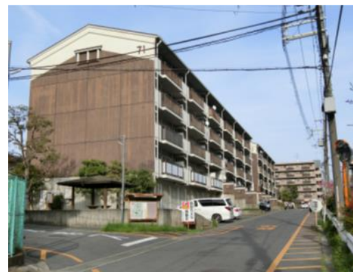
酒蔵外観デザインの71号棟と団地中央通路
