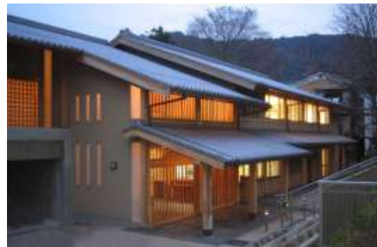
写真 6-1 京都市文化財保存技術研修センター
