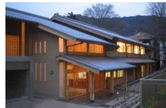
写真 6-1 京都市文化財保存技術研修センター
