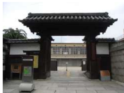
写真 2-40 京都市学校歴史博物館 (旧京都市立開智小学校(国登録有形文化財))
