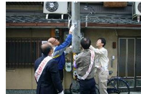
写真 7-27 屋外広告物の簡易除却
