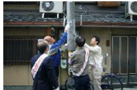
写真 7-27 屋外広告物の簡易除却
