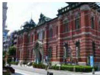
写真 3-14 三条通地区 (界わい景観整備地区)
