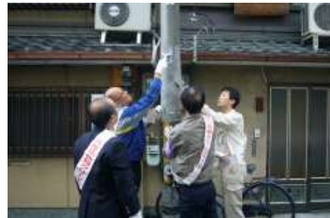
写真 7-27 屋外広告物の簡易除却
