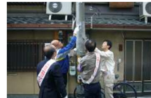
写真 7-27 屋外広告物の簡易除却
