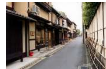
写真 3-13 上京小川地区 (歴史的景観保全修景地区)
