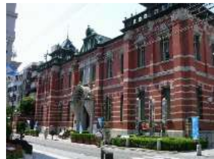
写真3-14 三条通地区 (界わい景観整備地区)
