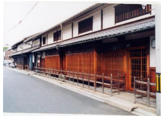
写真2-65 西陣の町並み
