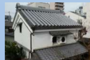
改修補助事例（葺屋根修理工事）
