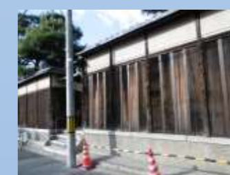
改修補助事例（塀修理工事）
