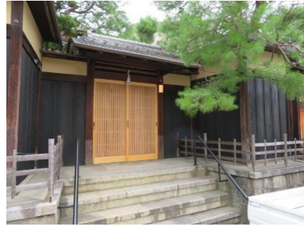
修景後(塀等修景工事)
