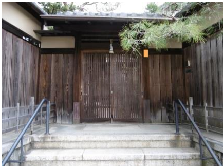
修景前(塀等修景工事)
