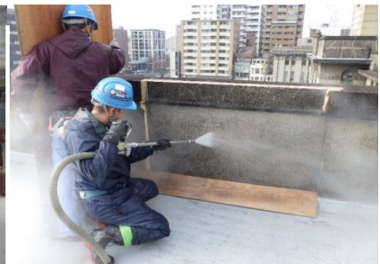
外壁洗浄試験
