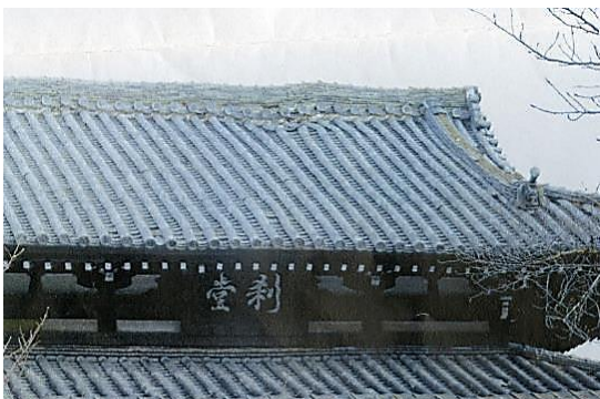
市指定文化財・立本寺刹堂 屋根 修理前
