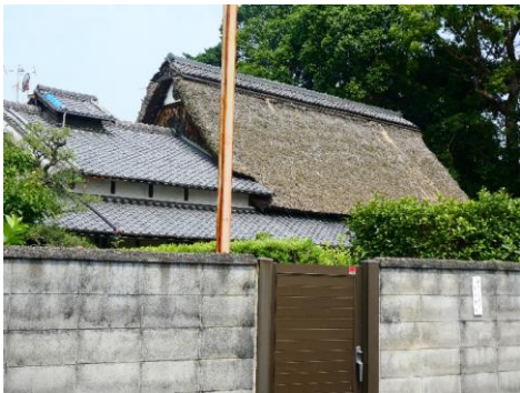
修理前 (茅葺屋根修理工事)
