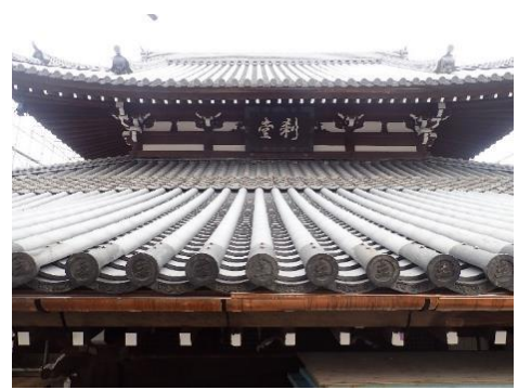
市指定文化財・立本寺刹堂 屋根 修理後
