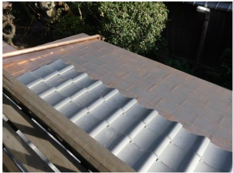
修理後 (銅板葺屋根修理工事)
