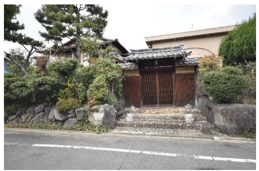
【岐美家】修理後 (外壁修理, 2階増築部分の撤去)
