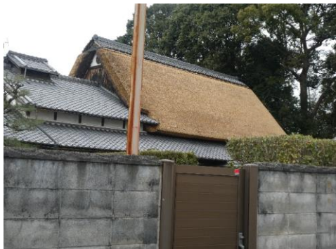
修理後 (茅葺屋根修理工事)
