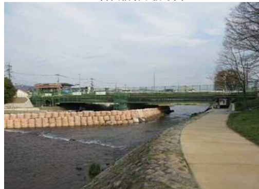
御園橋現況写真
