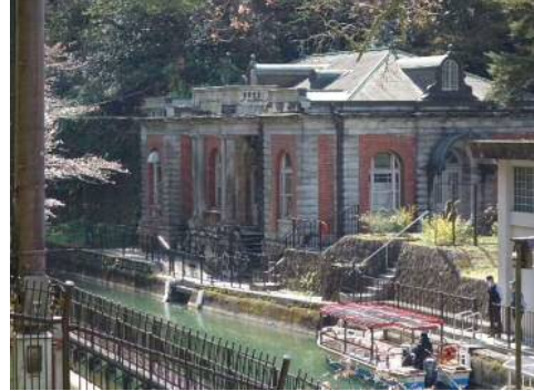
旧御所水道ポンプ室(国登録有形文化財)
