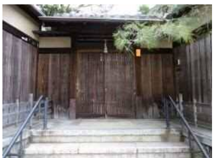
修景前(塀等修景工事)
