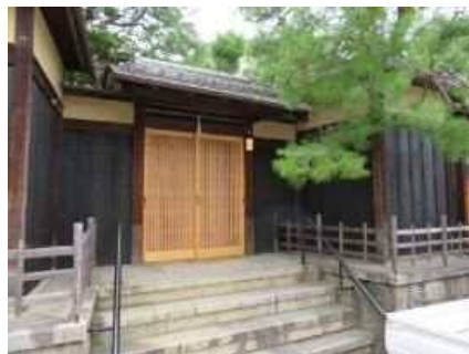
修景後(塀等修景工事)
