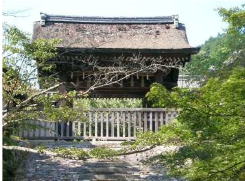
市指定文化財・毘沙門堂 修理前
