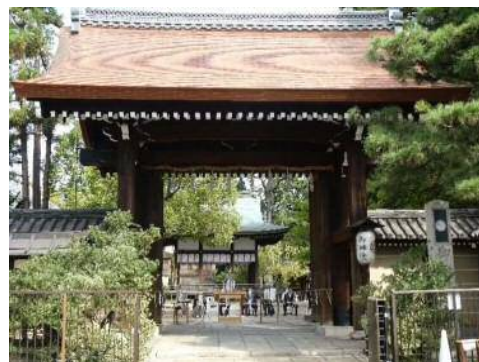
修理後 (門屋根修理工事)
