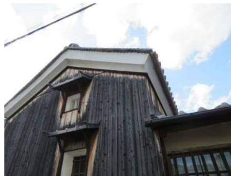
修理後 (蔵外観修理工事)
