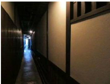
修理後(通路外壁工事)
