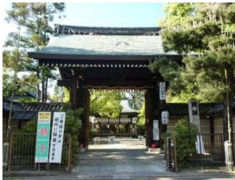
修理前 (門屋根修理工事)
