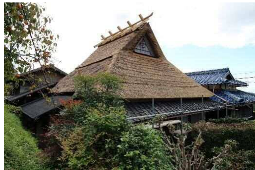
【平井家】修理後(茅葺き屋根葺替え)
