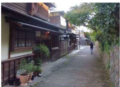
神楽岡旧谷川住宅群 改修前
