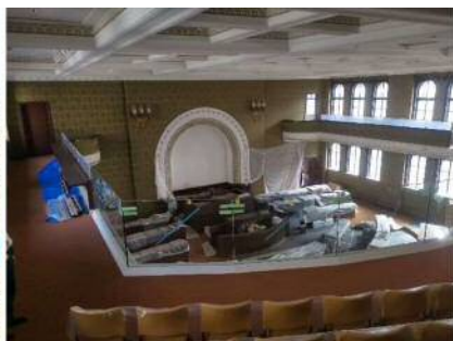
議場施工状況
