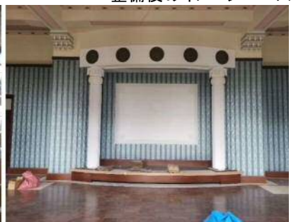
政庁の間施工状況
