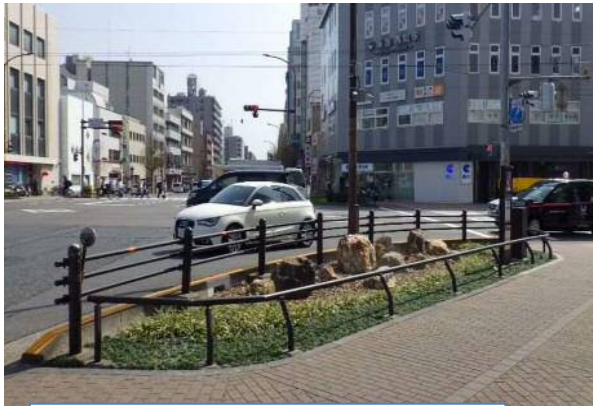
R2 整備箇所(西大路四条交差点北西角)
