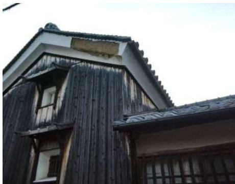
修理前 (蔵外観修理工事)
