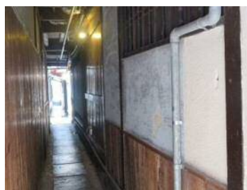
修理前(通路外壁工事)
