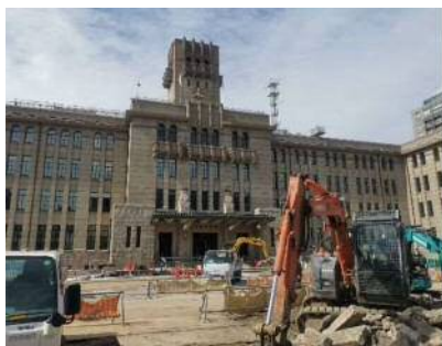
外観補修工事の状況
