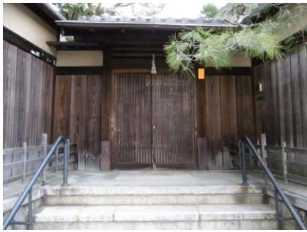
修景前(塀等修景工事)
