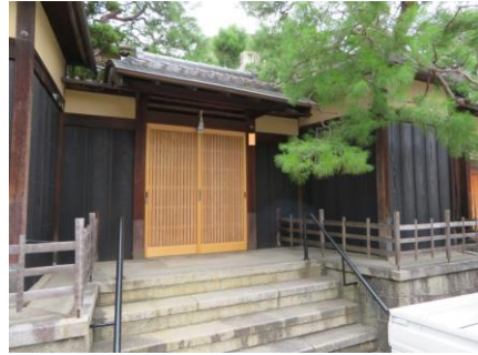
修景後(塀等修景工事)
