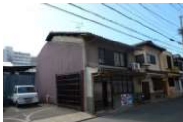
高井邸 改修前
