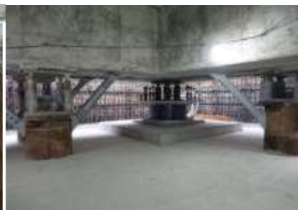
免震装置設置
