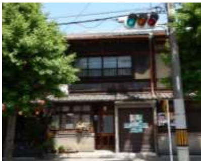
西森邸 改修前
