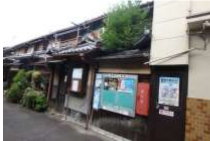
空き家活用・流通支援等補助金を利用した市外からの移住者住まいとしての活用(改修前)
