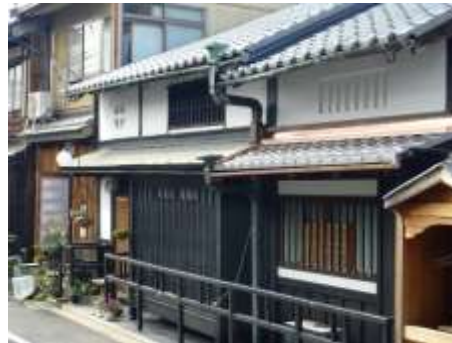
改修後(庇改修工事)
