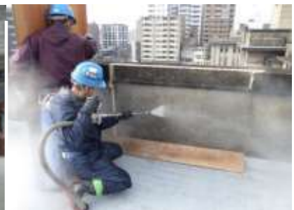
外壁洗浄試験
