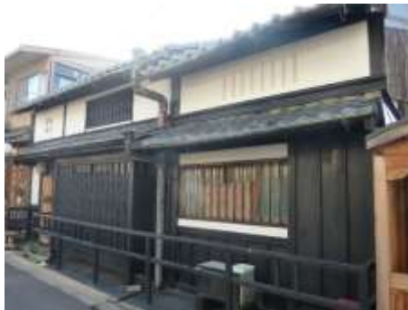
改修前(庇改修工事)
