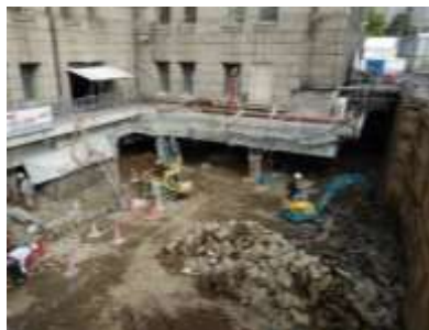
免震改修工事の状況
