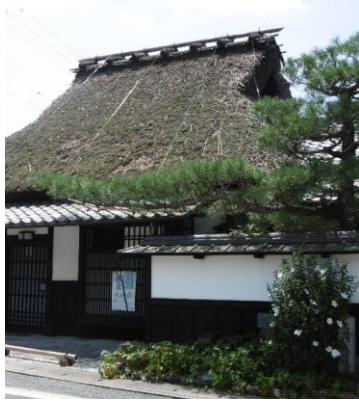
修理前 (屋根修理工事)
