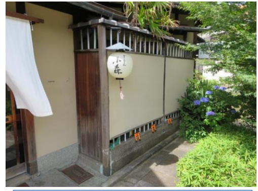
修理・修景前 (主屋下屋根等修理修景)
