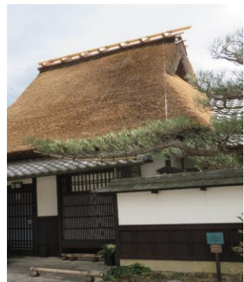
修理後 (屋根修理工事)
