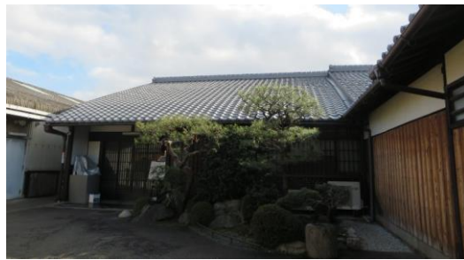
修理後 (屋根修理工事)
