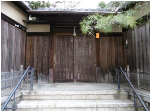
修理前 (主屋屋根外壁等修理)
