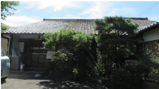
修理前 (屋根修理工事)
