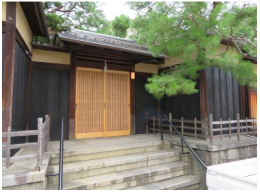
修理後 (主屋屋根外壁等修理)
