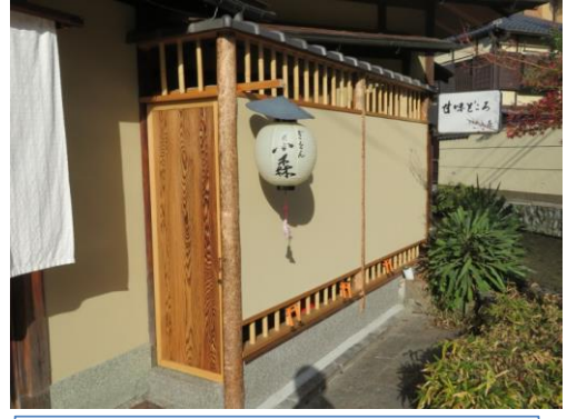
修理・修景後 (主屋下屋根等修理修景)
