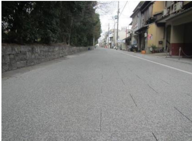
H30 整備箇所
