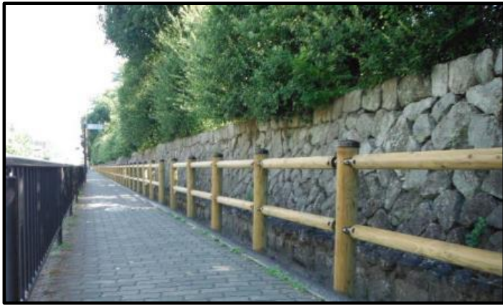
間伐材を使用した 転落防止柵の設置状況
