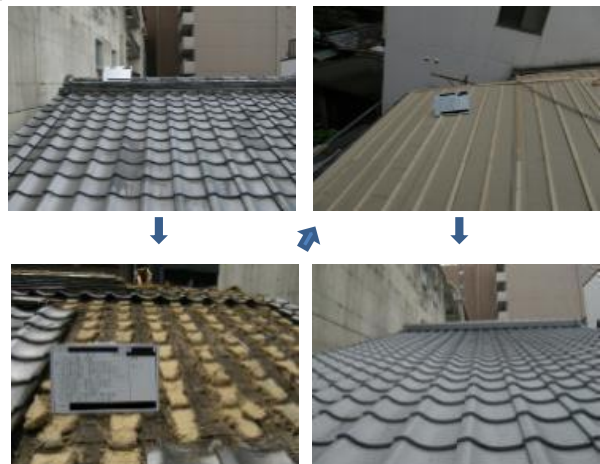
メニュー 屋根の軽量化 耐震改修工事状況
