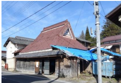
空き家活用×まちづくりモデルプロジェクトに採択されたわらしべの家プロジェクト(改修前)
