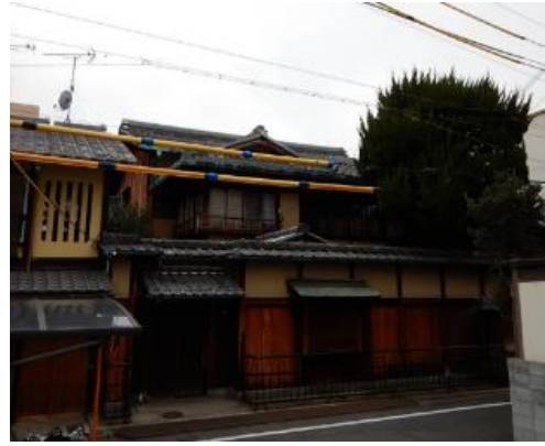
石田邸 改修後
