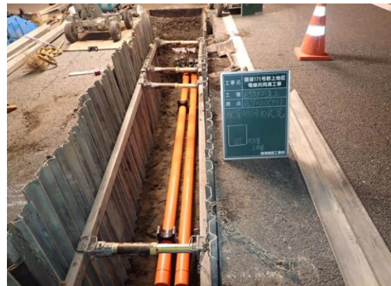
管路敷設状況
