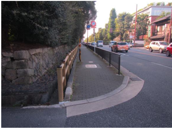
間伐材を使用した 転落防止柵の設置状況
