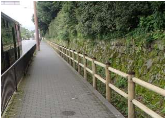
間伐材を使用した 転落防止柵の設置状況
