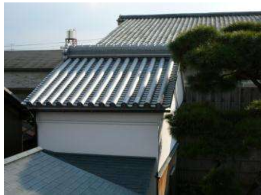
修理後 (蔵屋根修理工事)
