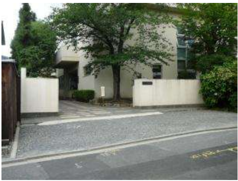
修理前 (門塀修景工事)
