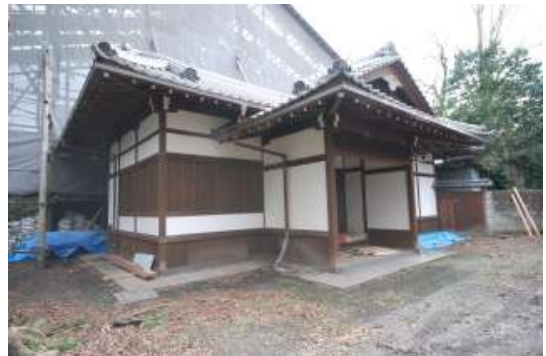
玄関棟修理工事(修理後)
