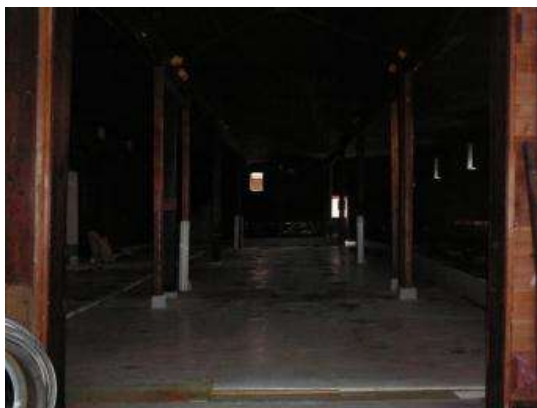
修理前 (耐震改修工事)
