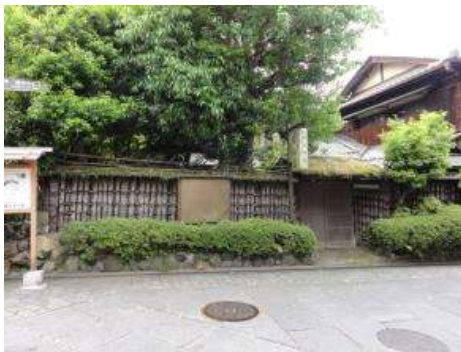
修理前 (門・建仁寺垣修理工事)
