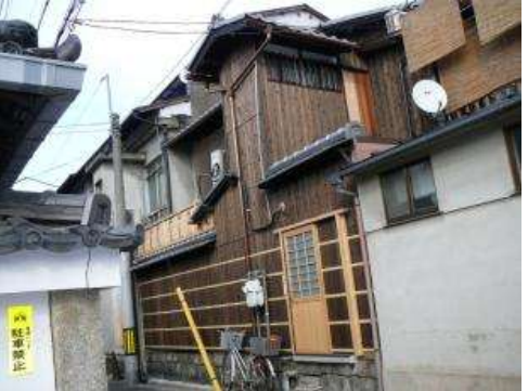
修理後 (屋根等修理工事)
