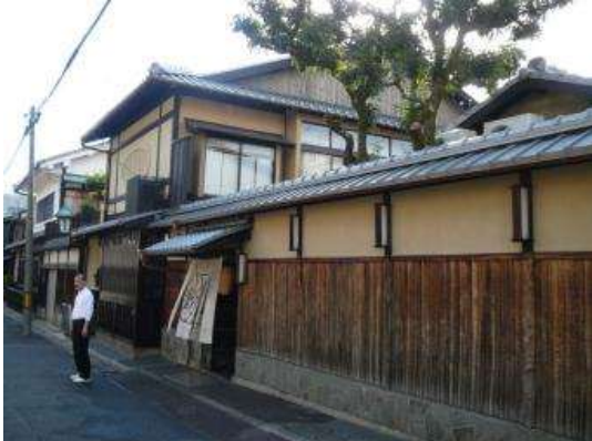
修理後 (屋根修理・主屋外壁修景工事)
