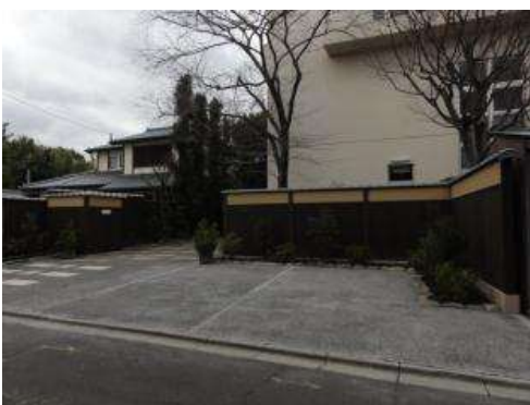
修理後 (門塀修景工事)
