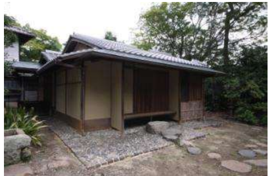
茶室修理工事(修理後)
