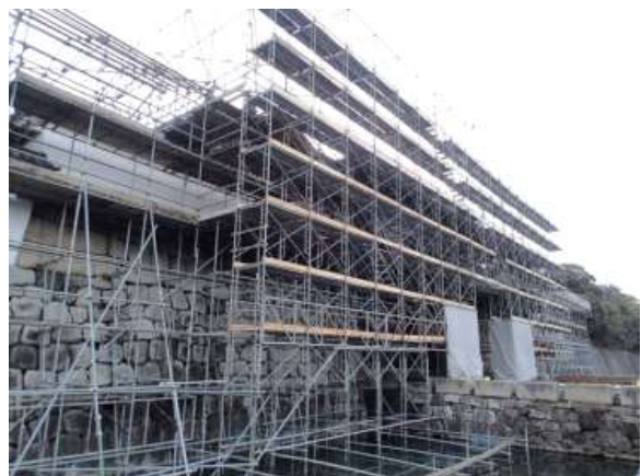
素屋根設置(施工中)
