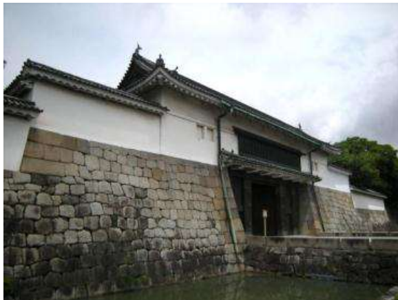
素屋根設置(施工前)
