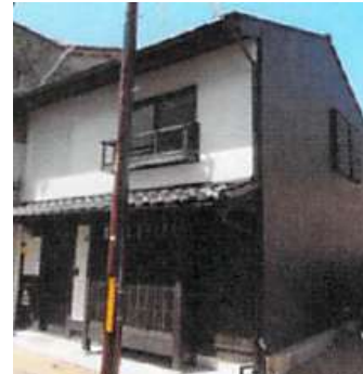
耐震改修後外観 (土壁の塗り直しや屋根瓦の)
