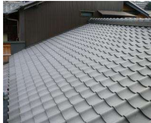
修理後 (玄関屋根修理工事)
