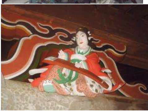
平岡八幡宮本殿彫刻 修理前 (彩色復原工事)
