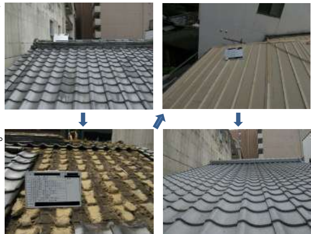
メニュー 屋根の軽量化 耐震改修工事状況
