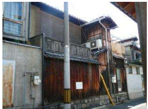
修理前 (屋根等修理工事)
