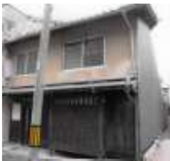
耐震改修前外観
