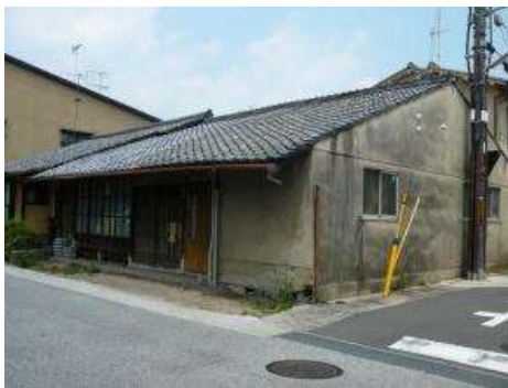
修理前 (外観修理工事)
