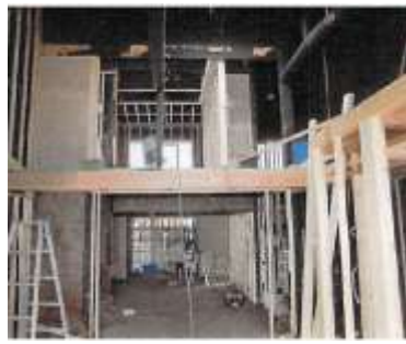
耐震改修工事状況 (土壁を新たに増設、2階の床組を補強するなどの耐震改修を)
