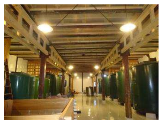
修理後 (耐震改修工事)
