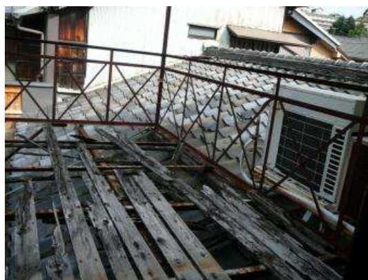
修理前 (玄関屋根修理工事)
