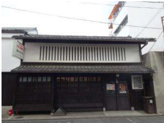
修理前 (屋根及び外壁修理工事)
