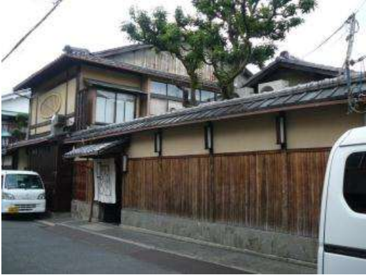
修理前 (屋根修理・主屋外壁修景工事)
