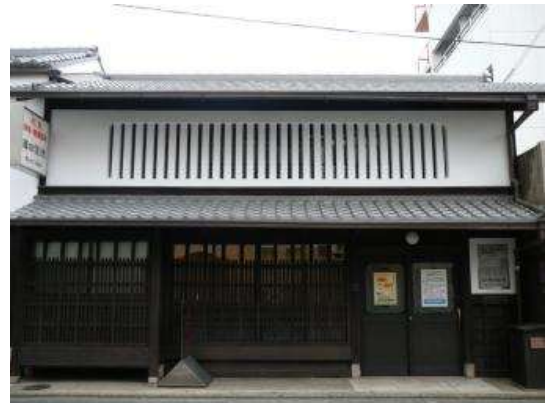
修理後 (屋根及び外壁修理工事)
