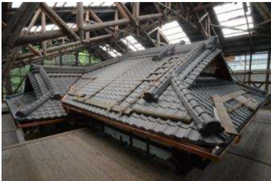
玄関棟修理工事(修理中)
