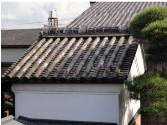
修理前 (蔵屋根修理工事)
