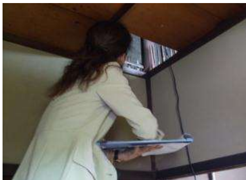
耐震診断現場調査状況
