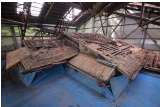
茶室修理工事(修理中)
