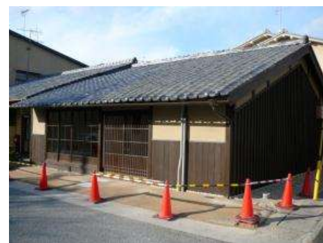
修理後 (外観修理工事)
