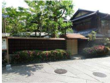
修理後 (門・建仁寺垣工事)
