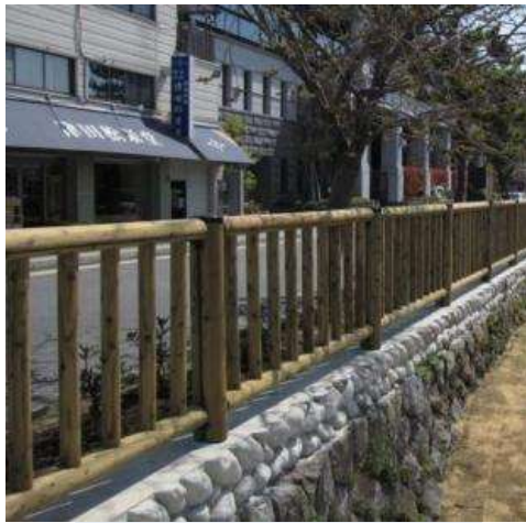
間伐材を使用した 転落防止柵のイメージ
