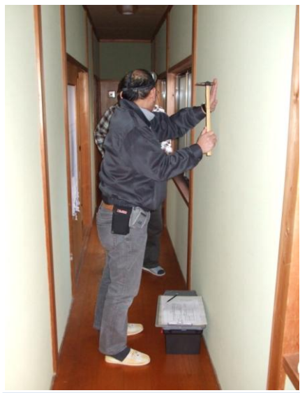
耐震診断現場調査状況
