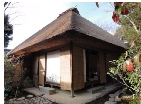
修理後(外壁修理及び塀修景工事)
