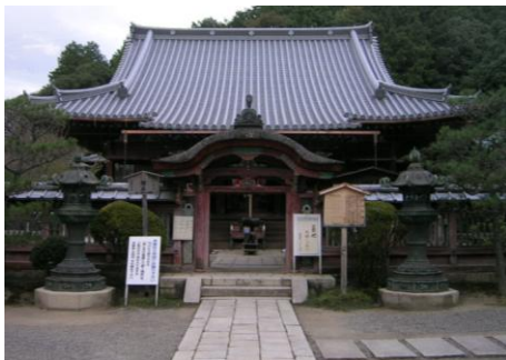
修理前(毘沙門堂本堂 塗装・飾金具工事)
