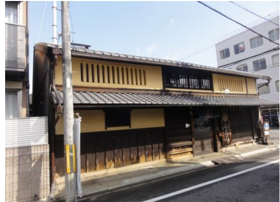
修理後(屋根修理工事)
