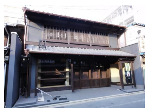
修景後(新築工事)
