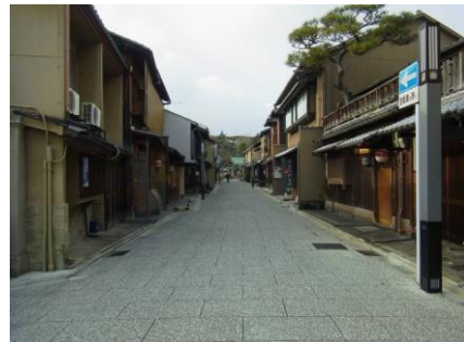
上七軒通 道路修景整備後の状況
