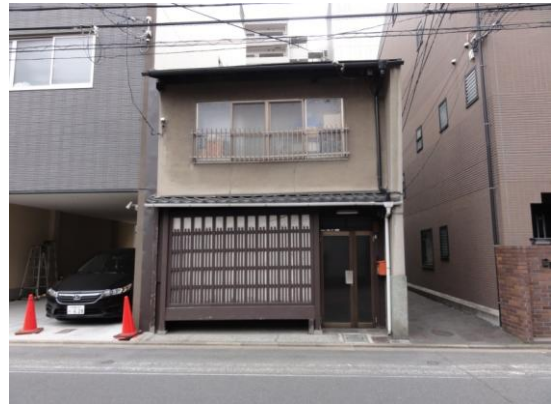
修理前(外壁修理工事)
