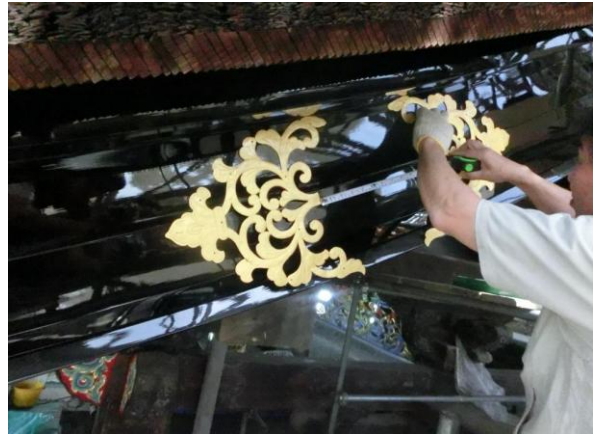
唐門修理(金具工事)
