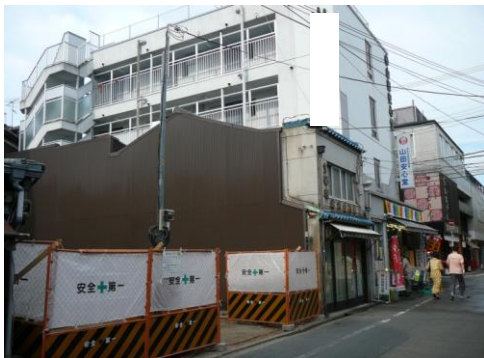
修景前(新築工事)
