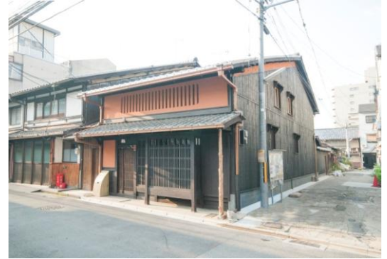
修理後(外壁・建具・屋根等修理工事)
