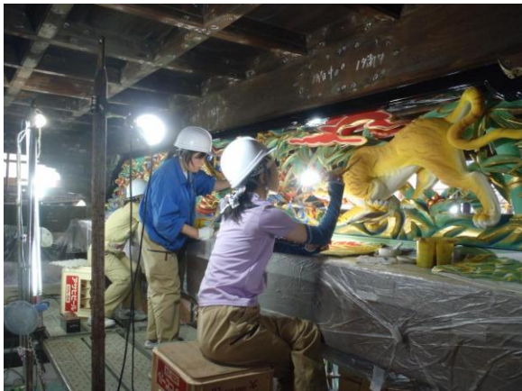
唐門修理(彫刻彩色工事)
