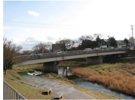
現況写真①
