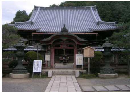
毘沙門堂本堂 修理前 (塗装・飾金具工事)
