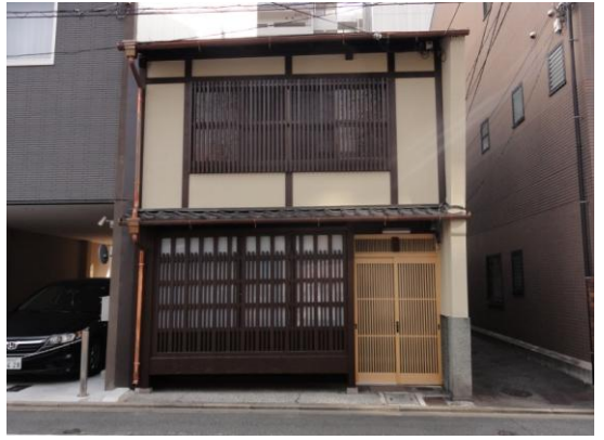
修理後(外壁修理工事)
