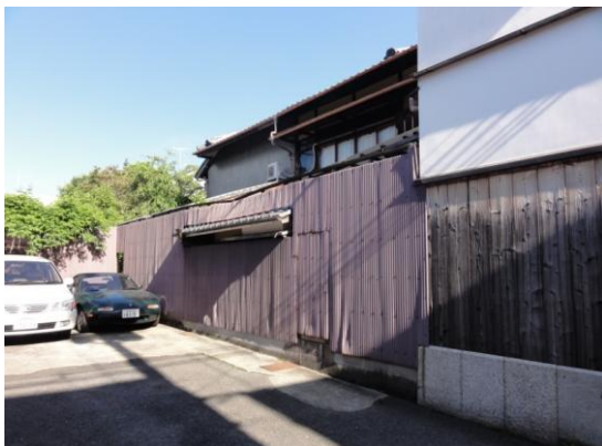
修理前(塀修景工事)
