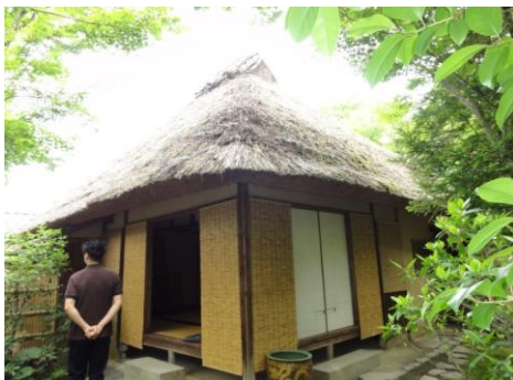
修理前(外壁修理及び塀修景工事)
