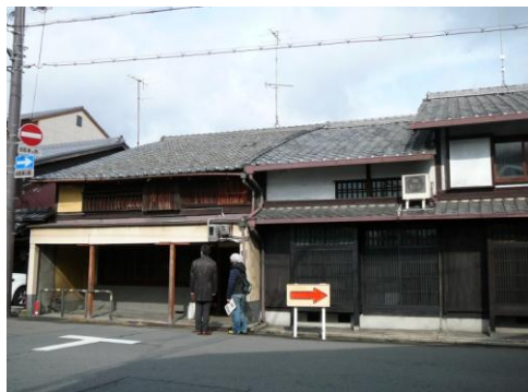
修理・修景前 (屋根修理及び外壁修景工事)
