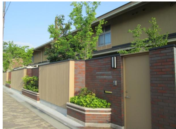
管理棟・病院
