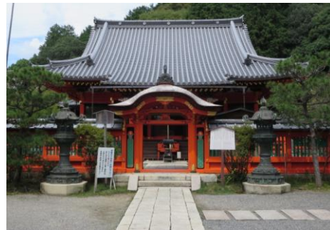
修理後(毘沙門堂本堂 塗装・飾金具工事)
