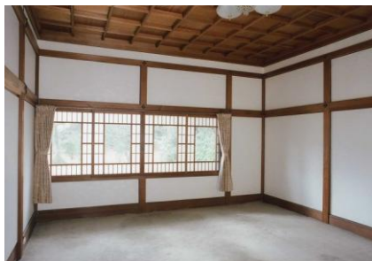
旧三井家下鴨別邸(玄関棟内部) 大正14年(1925)建築。天井の高い書院造を基調としているが、洋風生活に対応して椅子座のための絨毯敷仕様としている。
