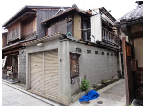
修理前(外壁修理及び塀修景工事)
