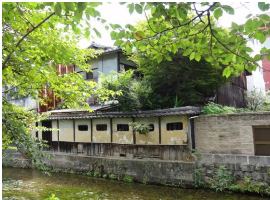
修理前(塀及び外壁修理・修景工事)
