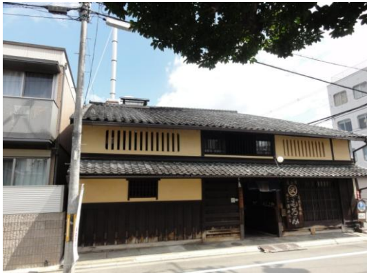
修理前(屋根修理工事)
