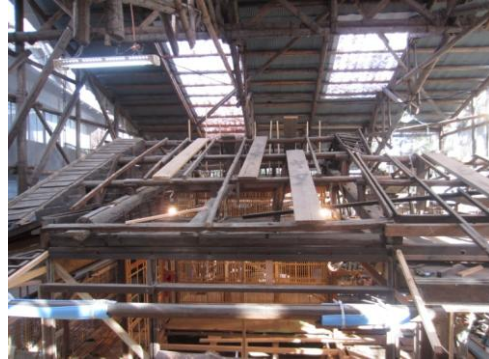
茶室修理工事(修理中)
