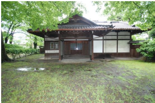
玄関棟修理工事(修理前)
