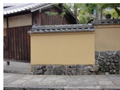
修理後(土塀修理工事)
