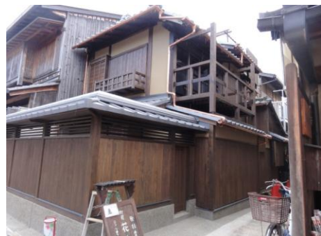
修理後(外壁修理及び塀修景工事)
