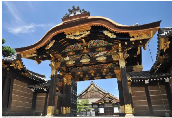
唐門・築地修理(完成)
