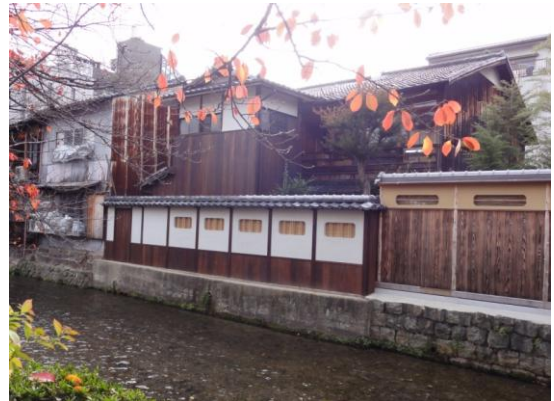
修理後(塀及び外壁修理・修景工事)
