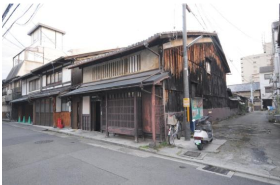
修理前(外壁・建具・屋根等修理工事)
