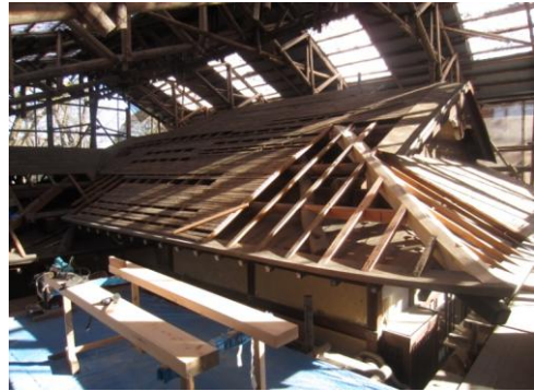
玄関棟修理工事(修理中)
