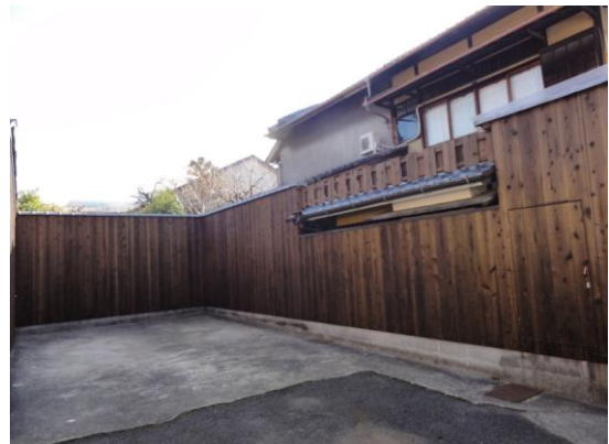
修理後(塀修景工事)
