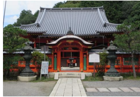
毘沙門堂本堂 修理後 (塗装・飾金具工事)
