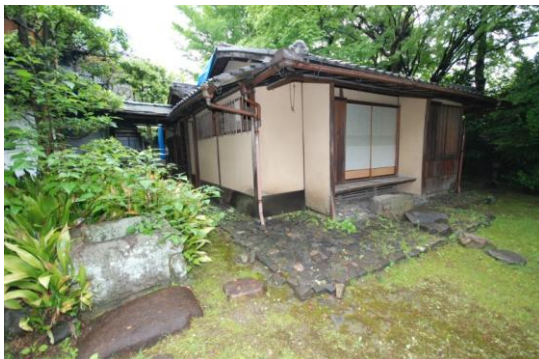
茶室修理工事(修理前)
