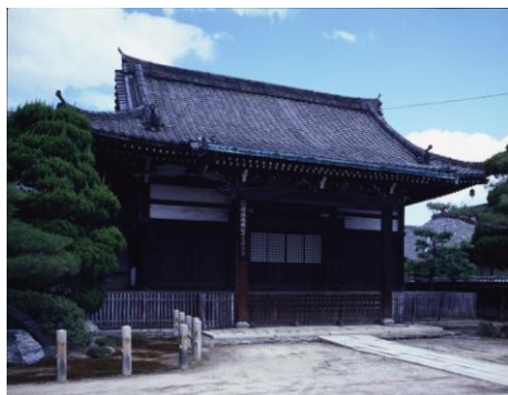
浄福寺 修理前 (屋根葺替工事)
