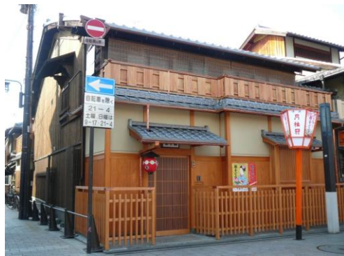
修理後(外壁等修理工事)
