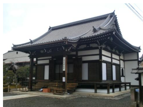
浄福寺 修理後 (屋根葺替工事)
