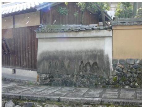
修理前(土塀修理工事)
