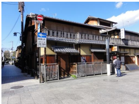
修理前(外壁等修理工事)
