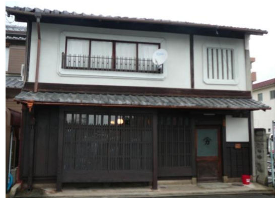
修理後(外壁・樋修理工事)
