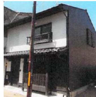
耐震改修後外観 (土壁の塗り直しや屋根瓦の)
