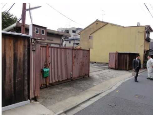
修理前(塀修景工事)
