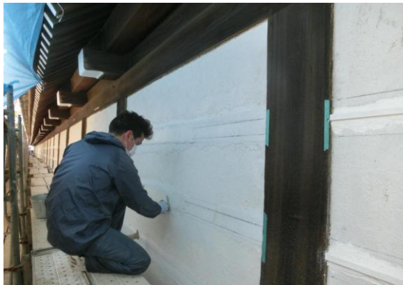
築地修理(左官工事)
