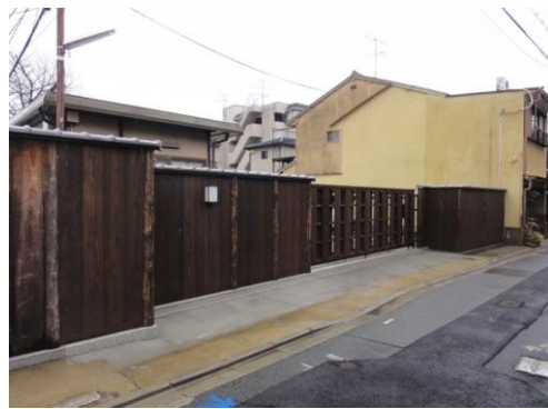
修理後(塀修景工事)
