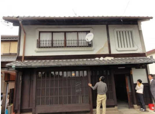
修理前(外壁・樋修理工事)
