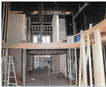
耐震改修工事状況 (土壁を新たに増設、2階の床組を補強するなどの耐震改修を)
