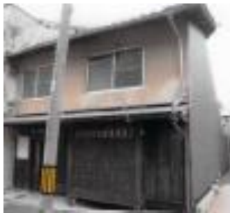
耐震改修前外観
