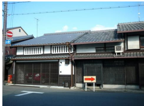
修理・修景後 (屋根修理及び外壁修景工事)
