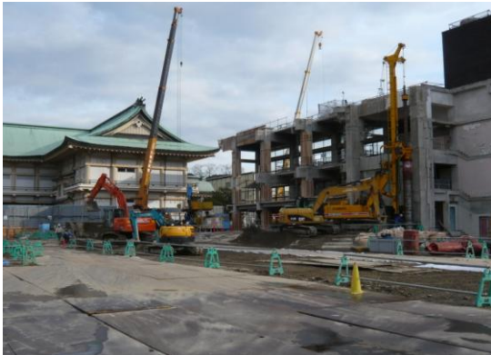
第1ホール解体工事の様子
