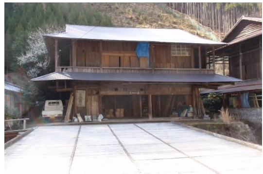
写真2-7-49 森久商店倉庫
