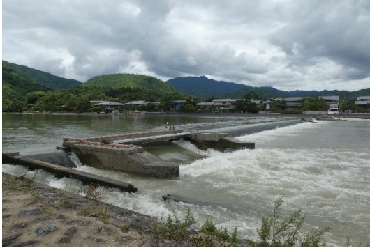
写真2-7-29 一ノ井堰(洛西用水)
