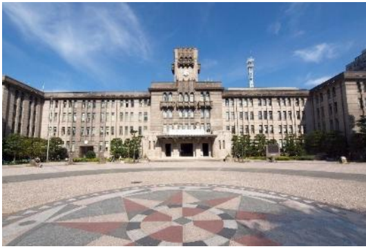
写真2-2-22 京都市役所本庁舎
