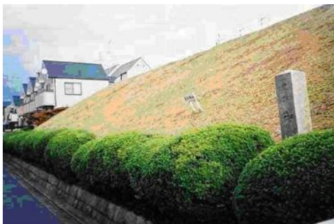
写真1-7 現在の御土居
