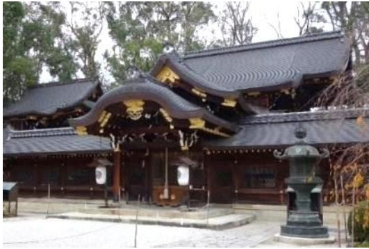
写真1-23 今宮神社幣殿・拝所・廻廊・本殿
