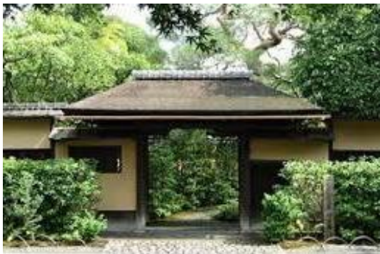
写真2-4-12 裏千家住宅（提供：裏千家）
