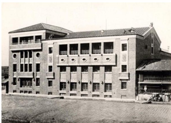
写真：大林組HP・実行実績から
