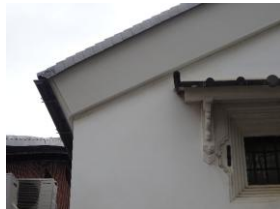
外観 台輪改修後
