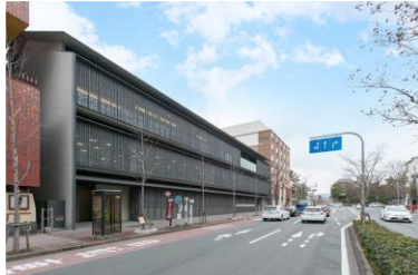
数研出版関西本社ビル (中京区)
