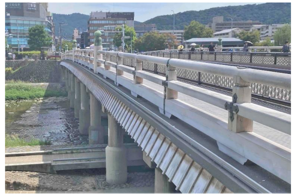
整備後（令和5年度）
