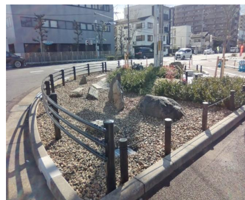
整備後（令和6年度）
