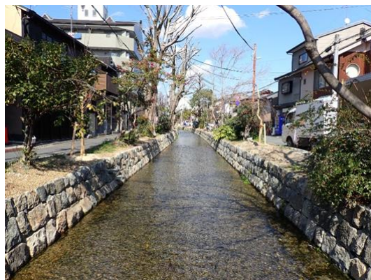
整備後（令和6年度）
