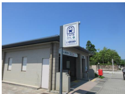
図表 2-3-8-13 地下鉄駅出入口電照式駅名標
