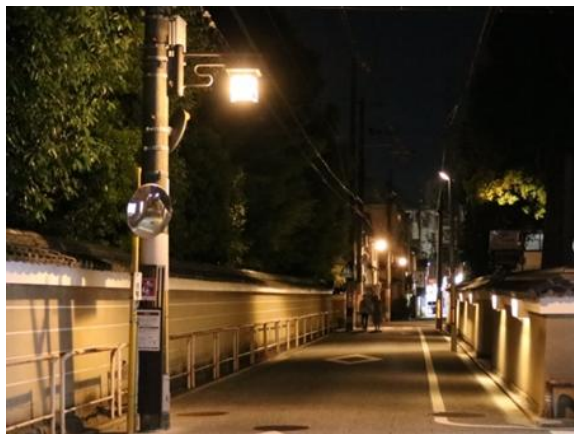
図表 2-3-2-12 道路照明灯のLED化
