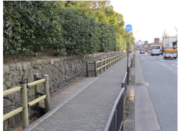
整備後（令和6年度）
