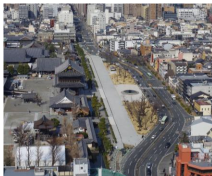
整備後（令和4年度）
