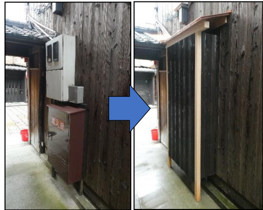
図表 2-6-11 町内会による消火栓の修景の補助
