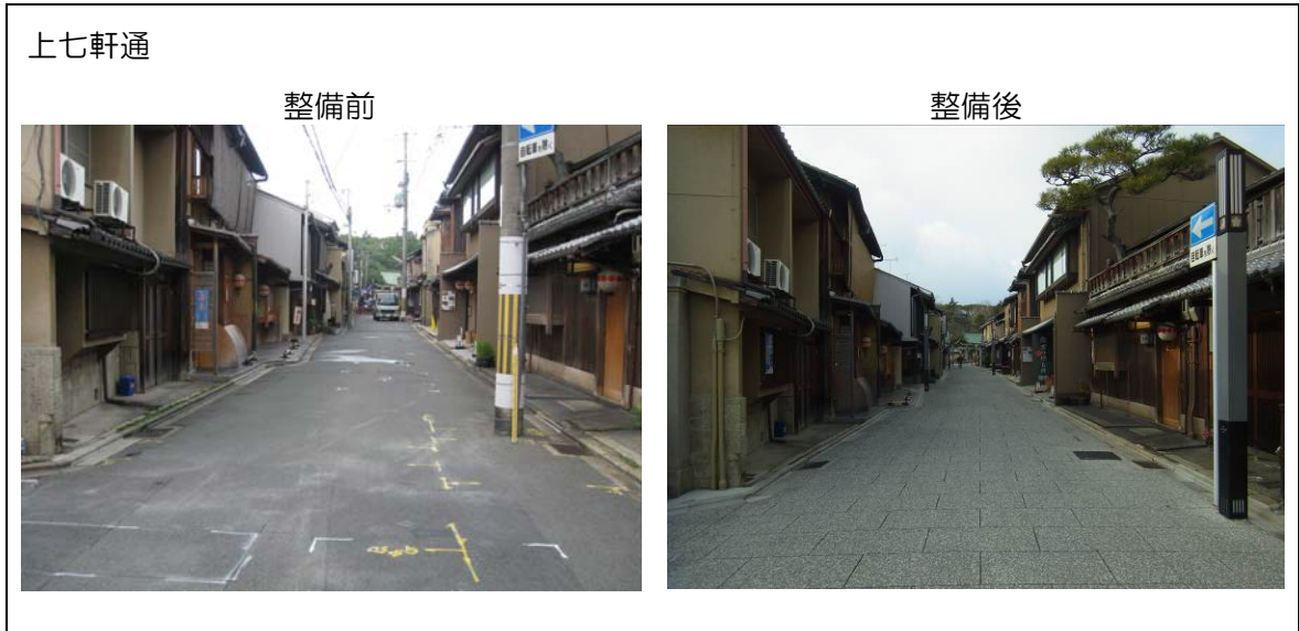
図表 2-46 無電柱化事業の事例
