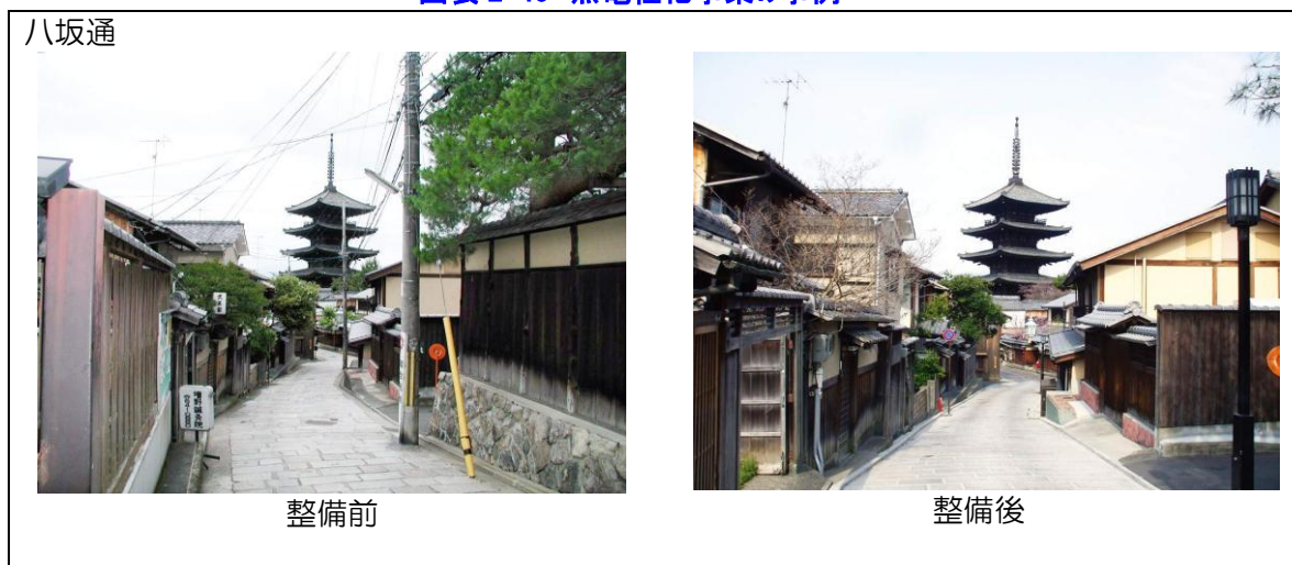
図表 2-46 無電柱化事業の事例
