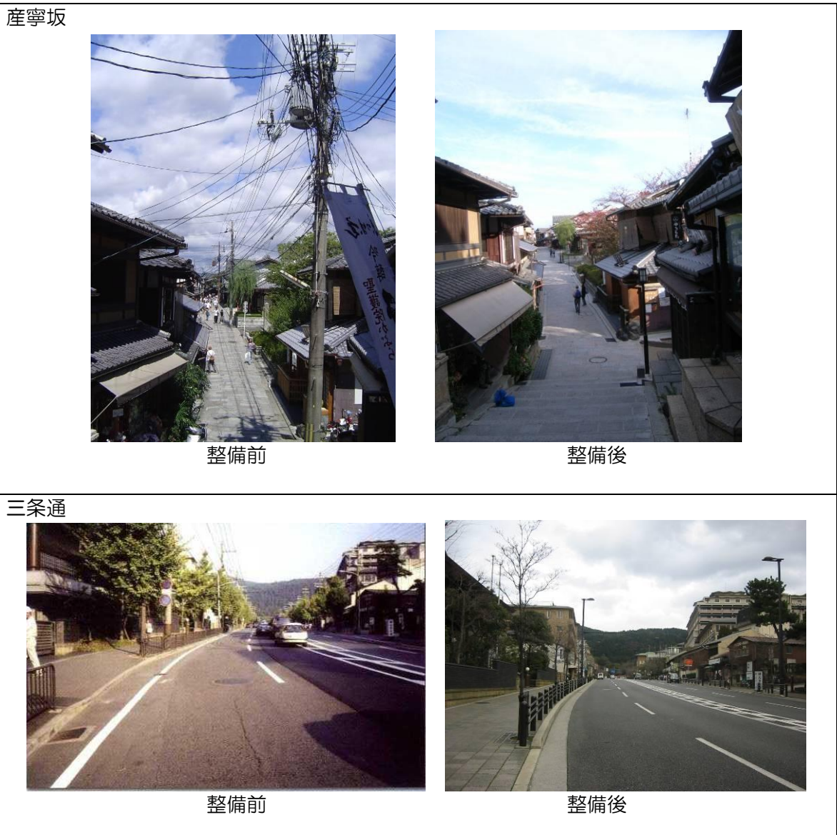
図表 2-46 無電柱化事業の事例
