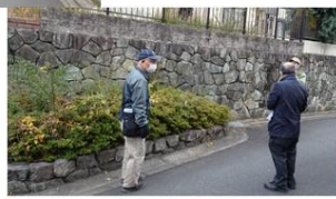
石の造形（擁壁）
