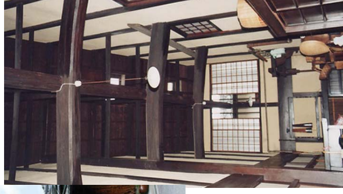
形成吹拔的 京町家厨房（火袋）
