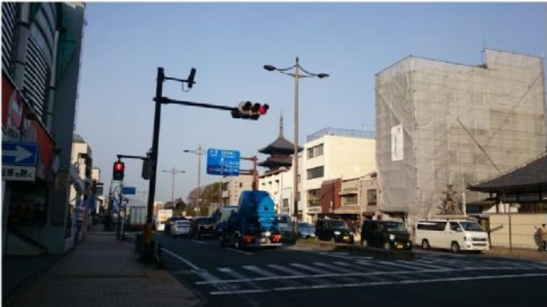
写真⑧ 九条通 (西向き)
