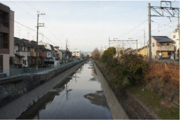
写真⑫ 疏水（北向き）
