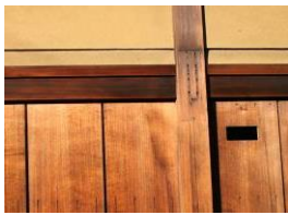
板張り及び土塗壁
