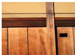
板張り及び土塗壁
