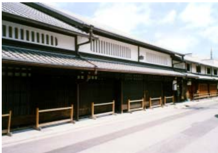
西陣美観地区（復元された織屋建ての町家）
