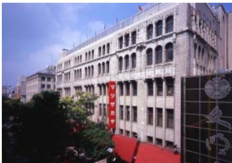
横浜松坂屋本館（平成16年度横浜市認定歴史的建造物）
