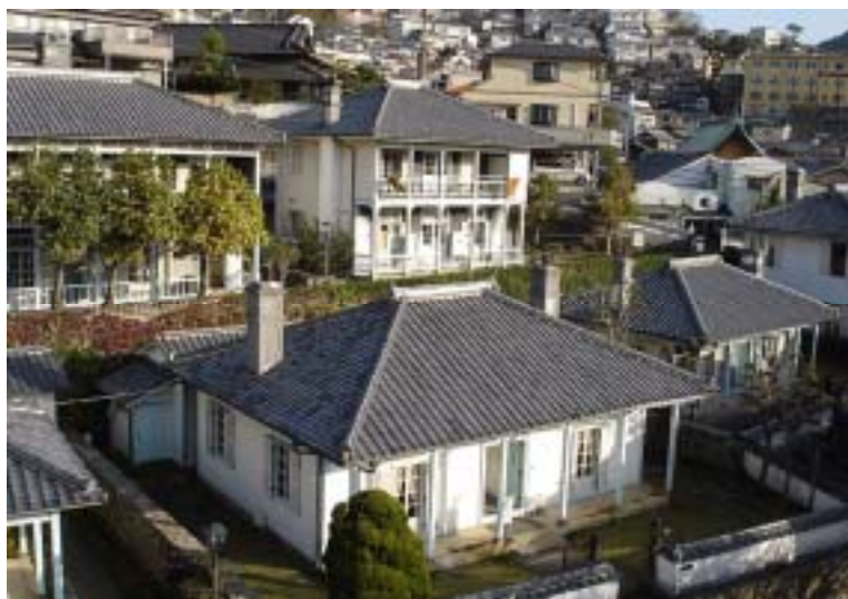
東山手地区（東山手伝統的建造物群保存地区）
